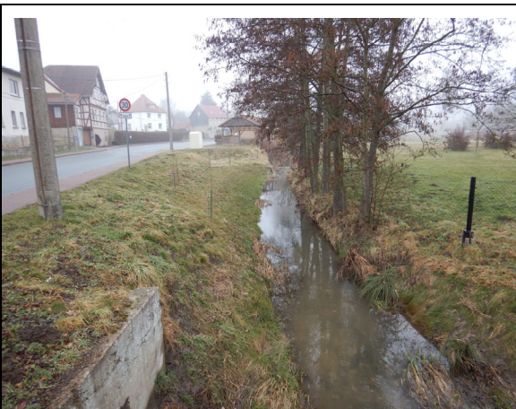
Abbildung 19: Umgesetzte Maßnahme zur Förderung der Eigendynamik im Landkreis Weimarer Land: kaum wirksam, da eingebaute Störstellen zu klein. © FBE 2020
