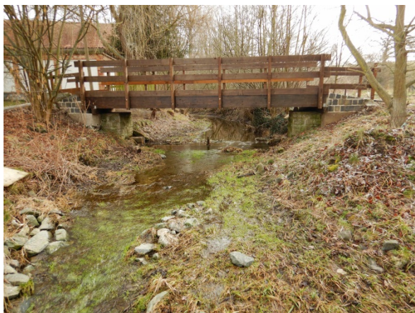
Abbildung 23: Am Schafbach im Ilmkreis wurde ein Querbauwerk als WRRL-MN (Nr. 9146) zurück gebaut, der Bach ist wieder durchgängig. © FBE 2021
