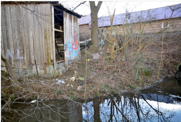
Abbildung 26: Müllablagerungen am Ufer des Grabens der der Wisenta vom Wehrteich in Schleiz zufließt. © FBE 2020.
