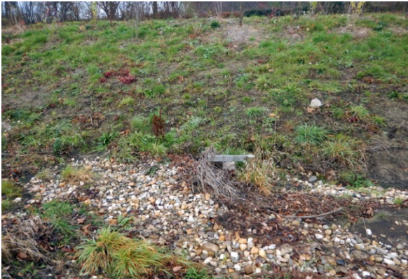
Abbildung 17: Fixierter Pfosten als „Totholz“ in einem renaturierten Gewässer in Erfurt. Als Habitat unwirksam und kaum strukturwirksam. © FBE 2020
